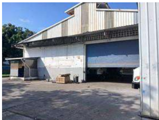
• Almacenaje de vehículos
