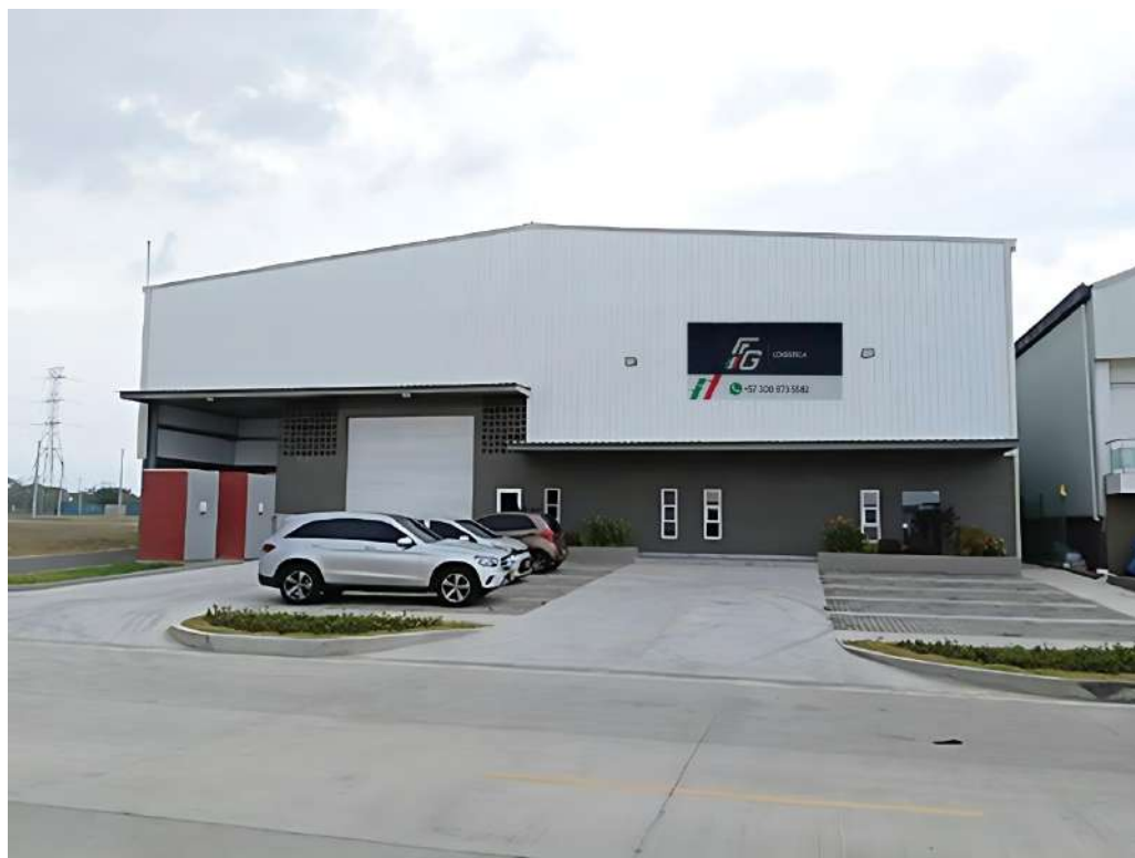
Bodega #36 que cuenta con un área Cubierta de 1.104,88m 2 y un área Descubierta de 506,2m 2
